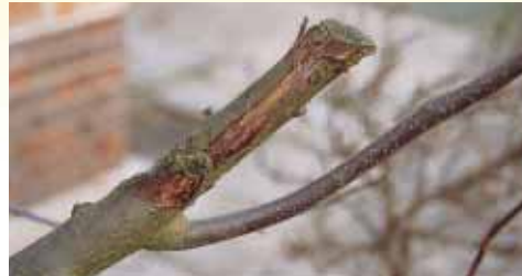
② Krankheitsbefall an stehengebliebenem Aststummel
